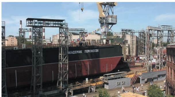
Рис. 2. Строительство ПАТЭС «Академик Ломоносов» на Балтийском заводе в Санкт-Петербурге
